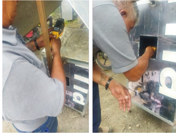
Figura 7. Medición de transferencia en panel encapsulado en fibras naturales de coco Nota. Durante esta fase se monitoreó la cara interna del panel para verificar la estabilidad de los 25 °C registrados frente a la radiación solar directa del exterior. Fuente: Elaboración propia (2026).
